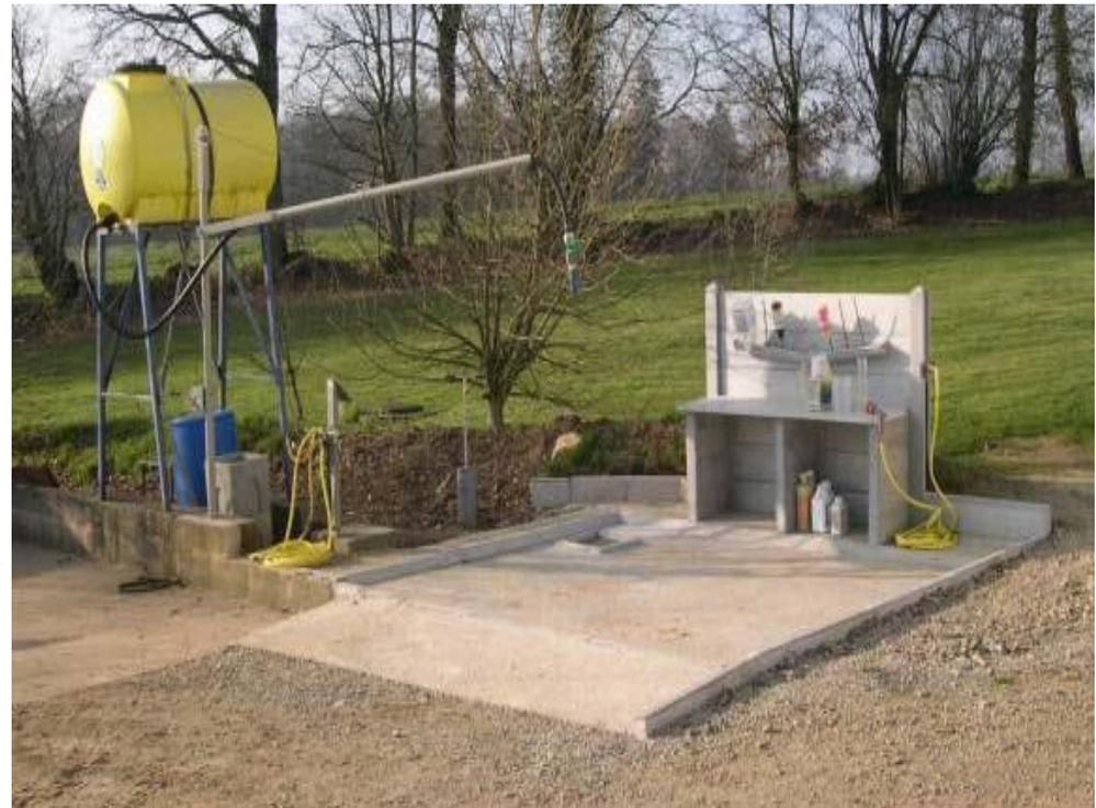
Il **lavaggio** può avvenire in aree autorizzate, definite “**biobed**”, cioè aree nelle quali immettere i residui delle soluzioni di PF rimasti nelle irroratrici e le acque utilizzate per il lavaggio di queste apparecchiature.
